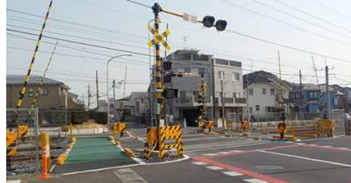
踏切改良(歩道拡幅)事例 (末広踏切)
