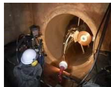
下水道管とマンホールの継手部耐震化
