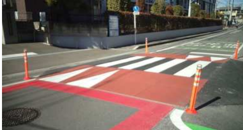
スムーズ横断歩道の整備事例 (生活道路対策エリア 「さいたま市大宮区三橋二・四丁目地区」)
