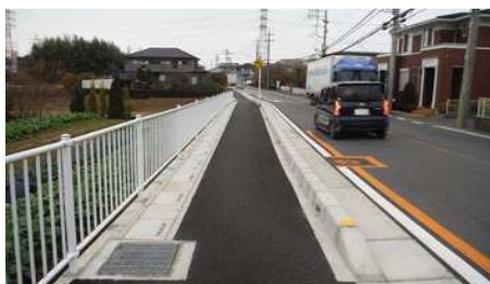
歩道整備事例 (一般県道蒲生岩槻線)
